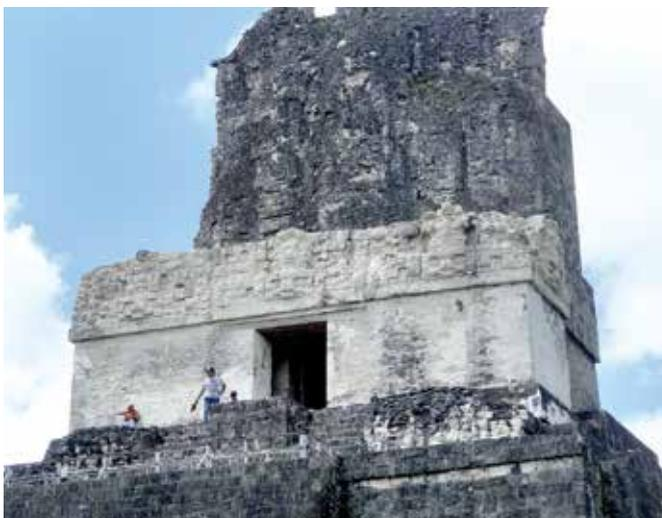
Foto 7. Friso o extradós decorado con relieves de estuco, recubierto con un adicionamiento o recubrimiento de sacrificio, cuyo color y textura se integran al resto del edificio. Trabajos efectuados bajo la asesoría de Enrique Monterroso. Fotos: Haydeé Orea. Octubre del 2015.
