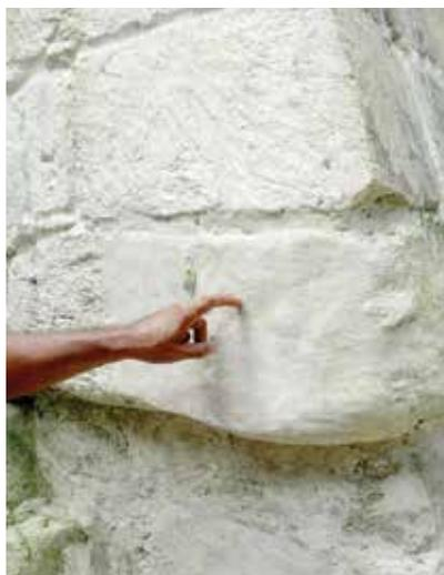
Foto 6. Muestra de un alujado o recubrimiento bruñado de cal y polvillo de piedra sobre una superficie vertical efectuada en una reciente intervención en Tikal, como la que se propone realizar en los edificios de Uaxactún.
