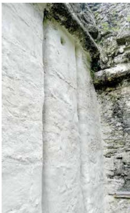
Foto 8: recubrimiento de sacrificio aplicado para proteger los sillares de un muro en el Palacio de las Acanaladuras en Tikal. Trabajo bajo la asesoría del Restaurador Enrique Monterroso. Octubre 2015. Foto: Haydeé Orea
